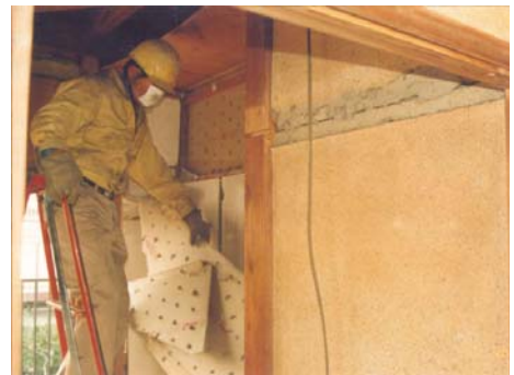
壁面の撤去状況
