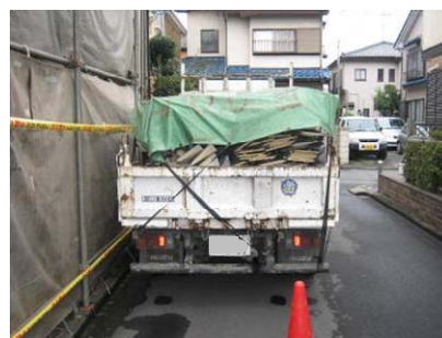
建設廃棄物の積載
