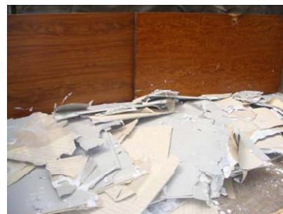
解体後の廃石膏ボードの保管
