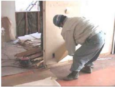
クロス類の撤去状況
