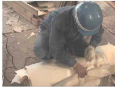
クロス類の結束状況
