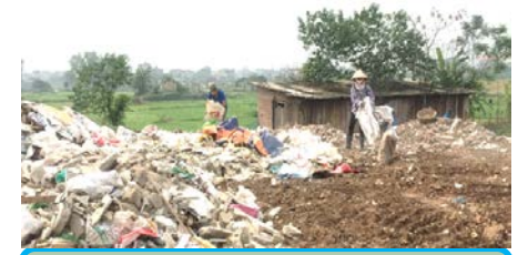
ハノイ市建設廃棄物処分場 ピックアップ中
