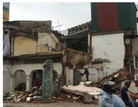
ハノイ市解体現場
