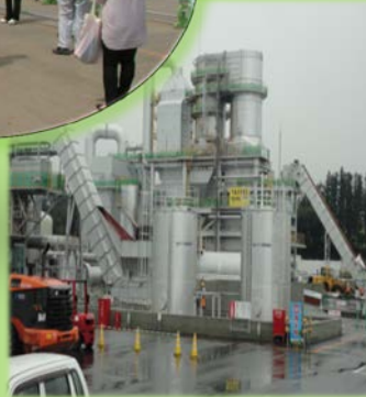
災害廃棄物処理プラント
